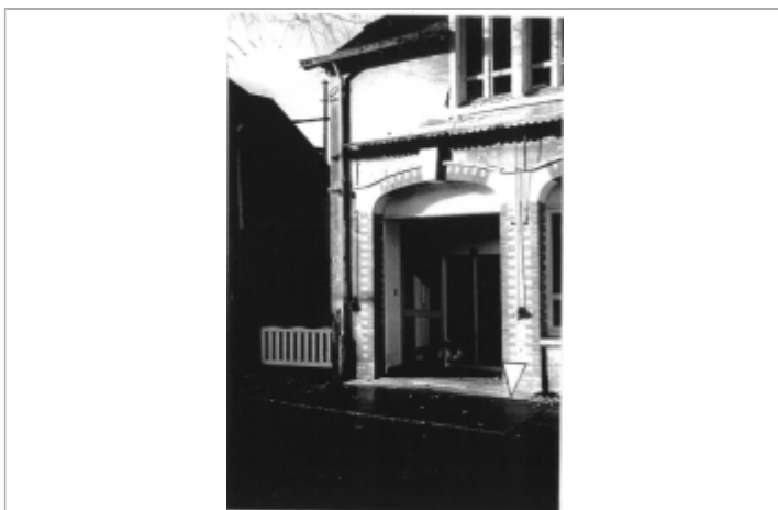
+1,20m Dalle béton devant porte du bureau d'accueil
