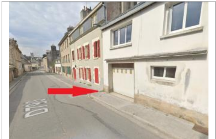
Entrée garage de la maison au 47 rue Brémond d'Ars
