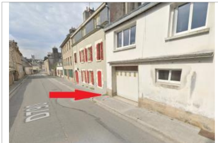
Entrée garage de la maison au 47 rue Brémond d'Ars
