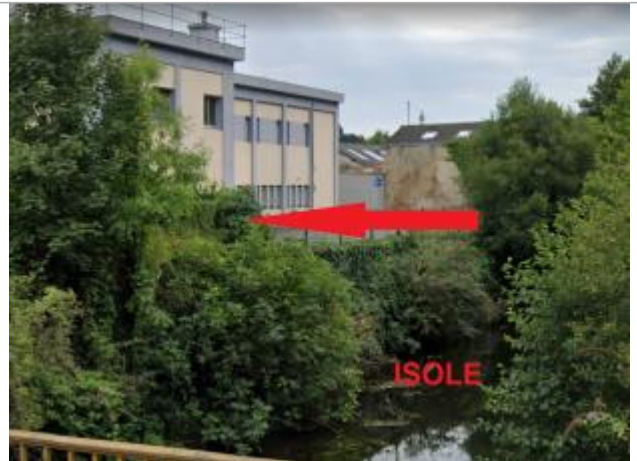
Bâtiment au 4 rue Alain Caniart, coté Isole
