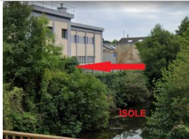
Bâtiment au 4 rue Alain Caniart, coté Isole
