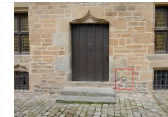
repère normalisé sur le coté des escaliers d'entrée d'une maison ancienne rue Dom Morice
