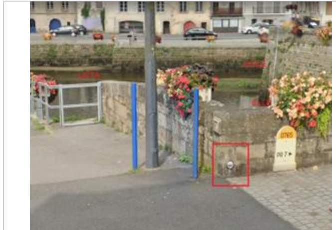
Pont du Bourgneuf (RD 765)
