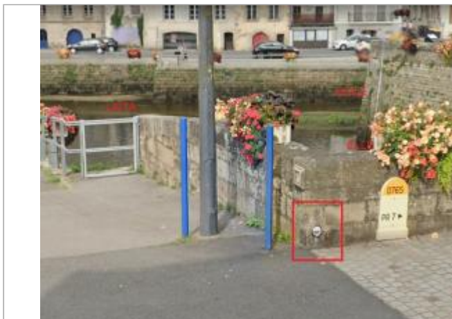
Pont du Bourgneuf (RD 765)
