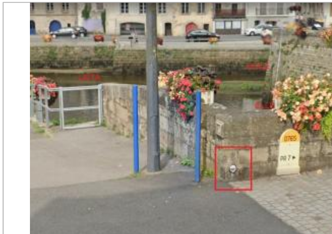
Pont du Bourgneuf (RD 765)
