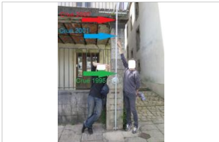
Perche de repères de crues au 9 quai Brizeux
