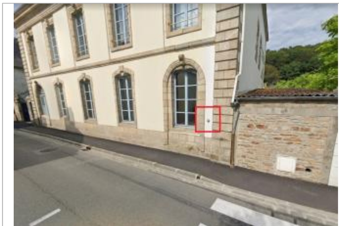
mur de l'école de musique coté rue Brémond d'Ars
