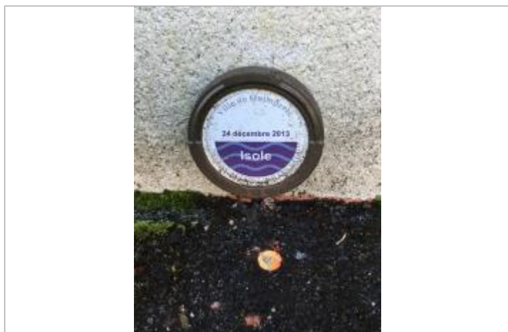
repère de décembre 2013 à l'angle du bâtiment place des anciennes fonderies
