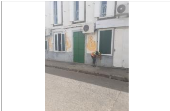
Façade extérieur d'un mur
