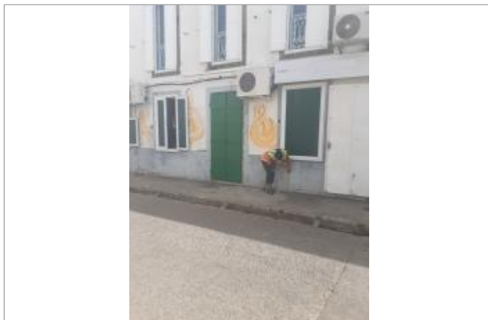
Façade extérieur d'un mur
