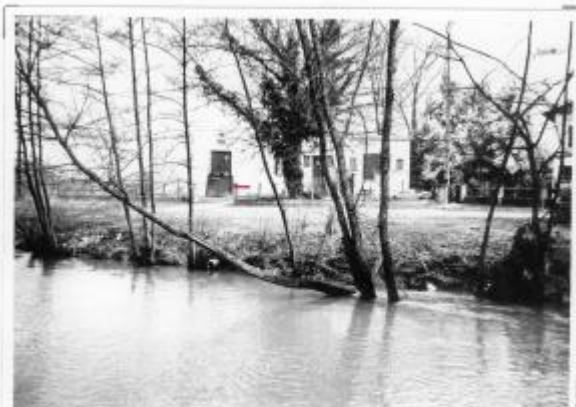
9 - Station de pompage - rive gauche
