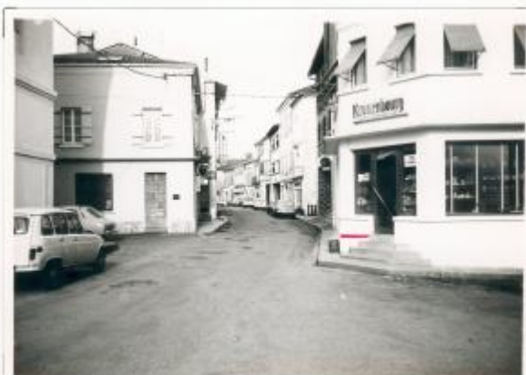
20 - Rue Duprat - Derrière la Mairie
