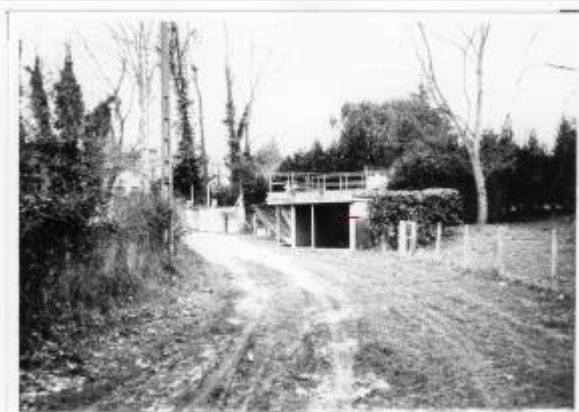
# - Station d'épuration - rive de l'ébé
