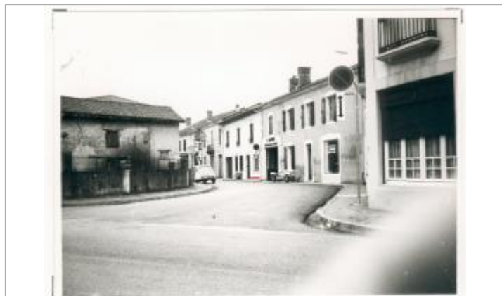
16 - Rue de l'Industrie - Vue depuis la Rue d'Orpèze
