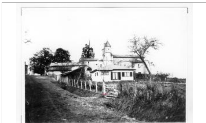
1 - Chemin d'accès à la Midouze
