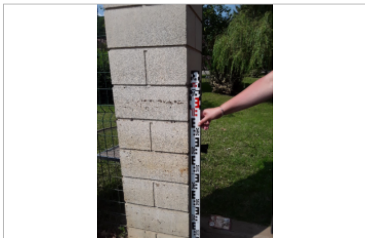
photo du repère de près
