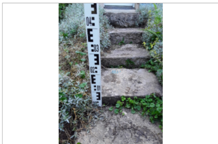
photo du repère de près
