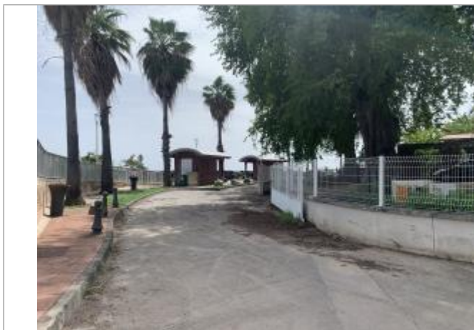
Muret de clôture blanc
