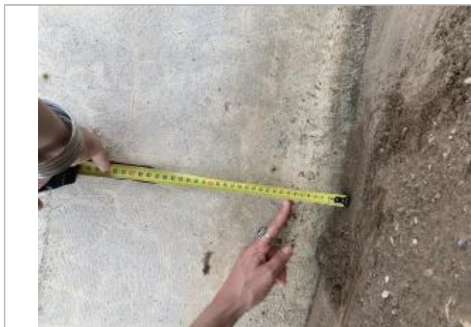
Dépôt de matières solides
