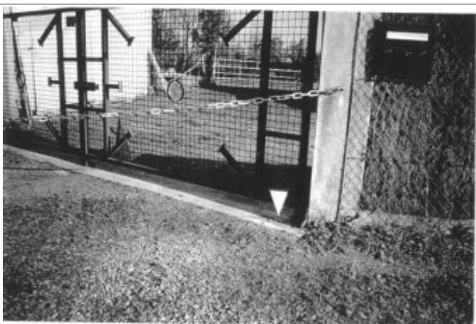
-0.40 m seuil porte garage
