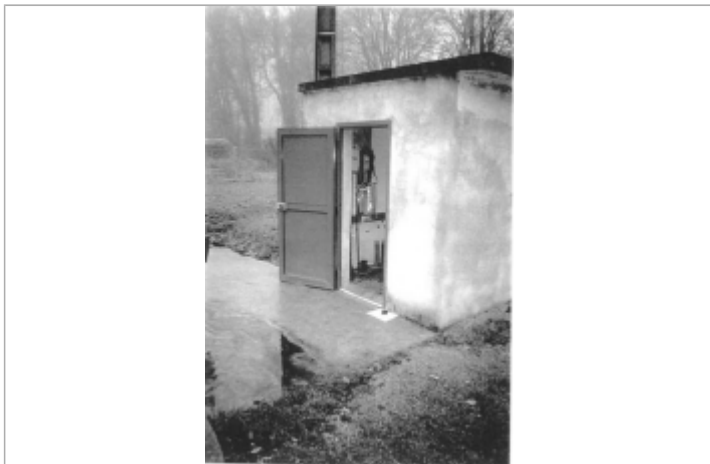
+60 cm dalle béton devant local technique
