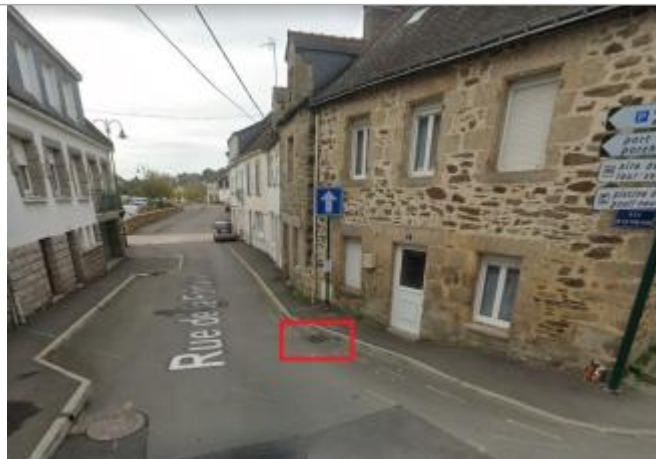
Grille eaux pluviales devant le n°2 rue de la Fontaine
