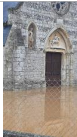
Vue de la crue.
