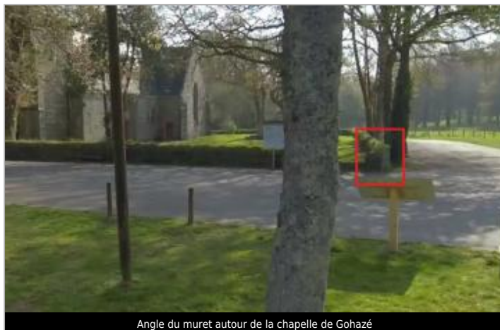
Angle du muret autour de la chapelle de Gohazé
