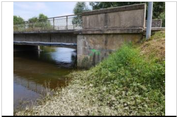
repère pont de voncq
