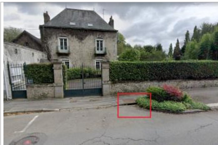
chaussée devant le n°157 rue nationale
