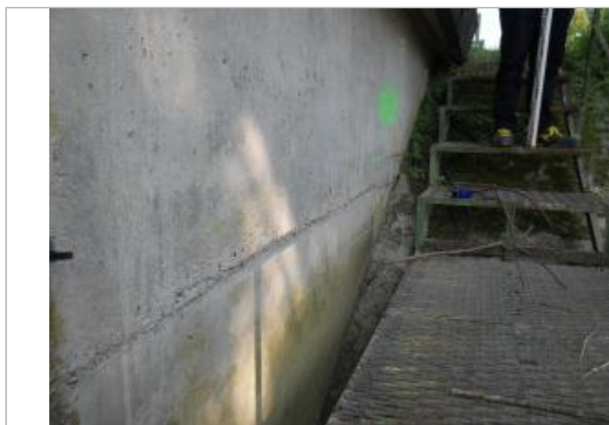
repère de crue pont de mouron
