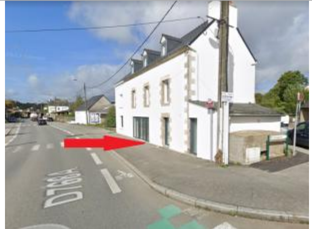
Bâtiment au 14 rue Albert de Mun
