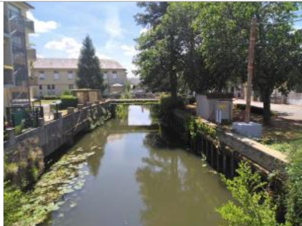
Bras de l'Aumône à l'aval du pont.
