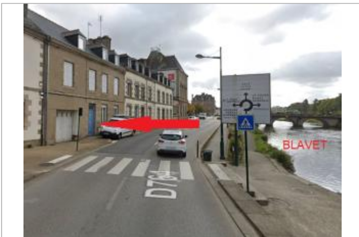
Garage au n°13 quai Niemen
