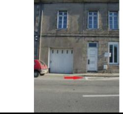
Rigole d'eaux pluviales se situant entre la route et le trottoir
