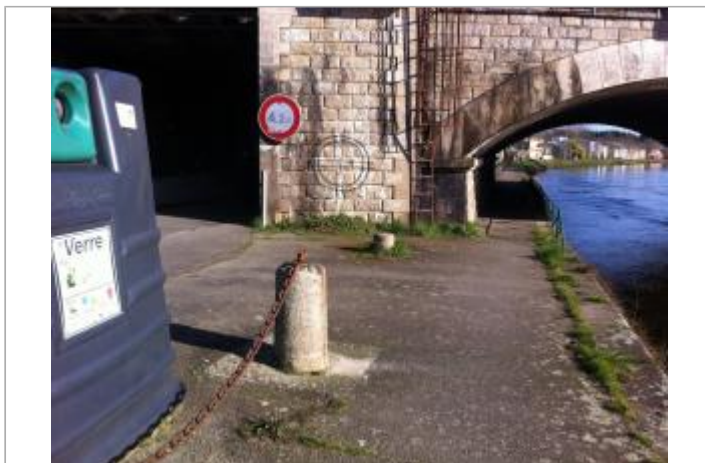
Pile du pont en amont
