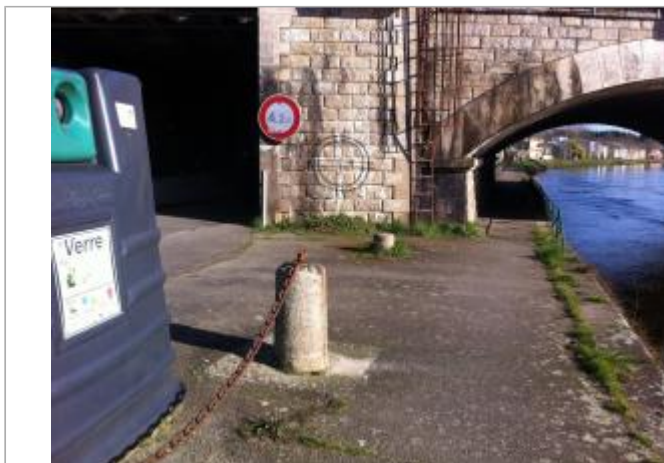
Pile du pont en amont
