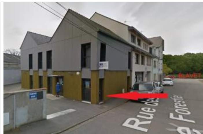
Bâtiment au 3 rue des 3 frères Leforestier
