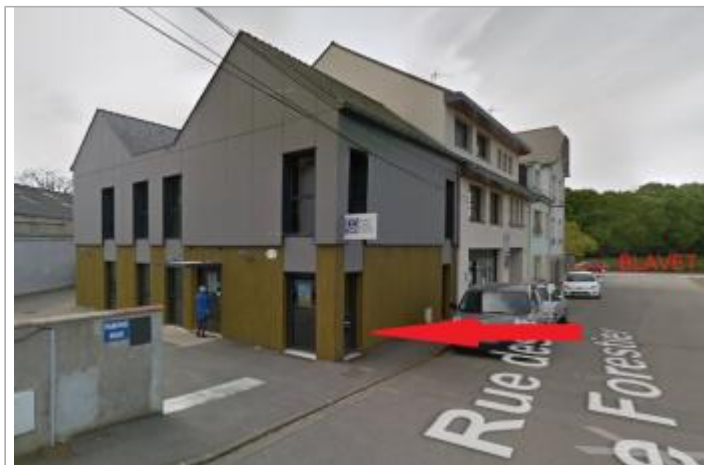
Bâtiment au 3 rue des 3 frères Leforestier
