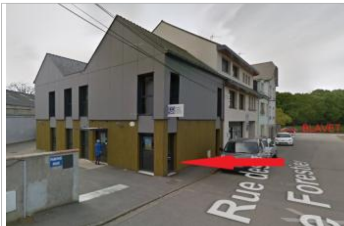
Bâtiment au 3 rue des 3 frères Leforestier
