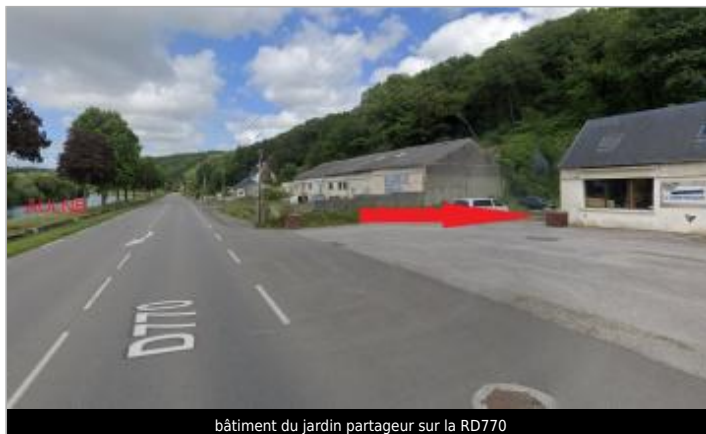
bâtiment du jardin partageur sur la RD770
