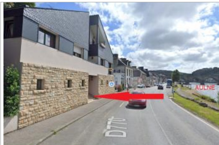
Maison au 60 quai Charles de Gaulle
