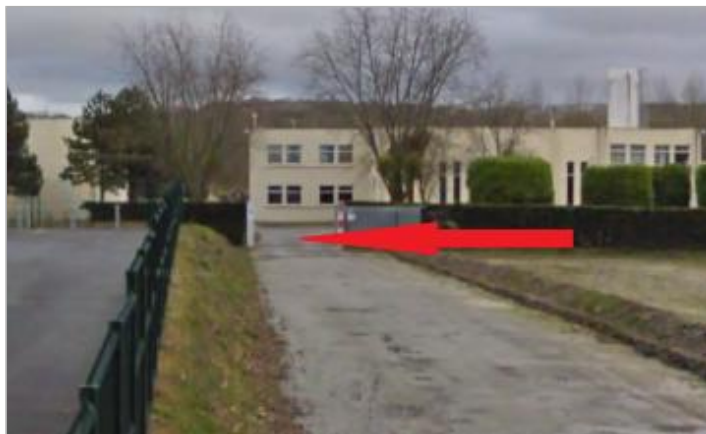
Chemin d'accès à l'usine de traitement de l'eau
