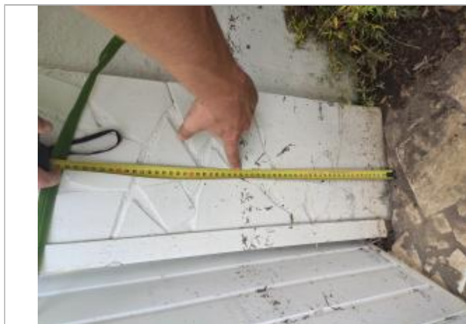
Dépôt de matières solides
