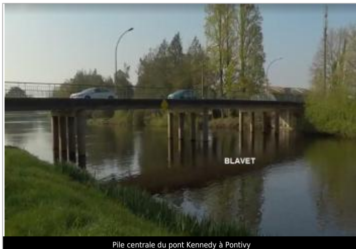
Pile centrale du pont Kennedy à Pontivy
