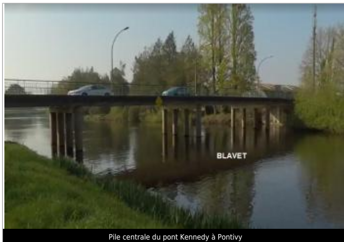
Pile centrale du pont Kennedy à Pontivy
