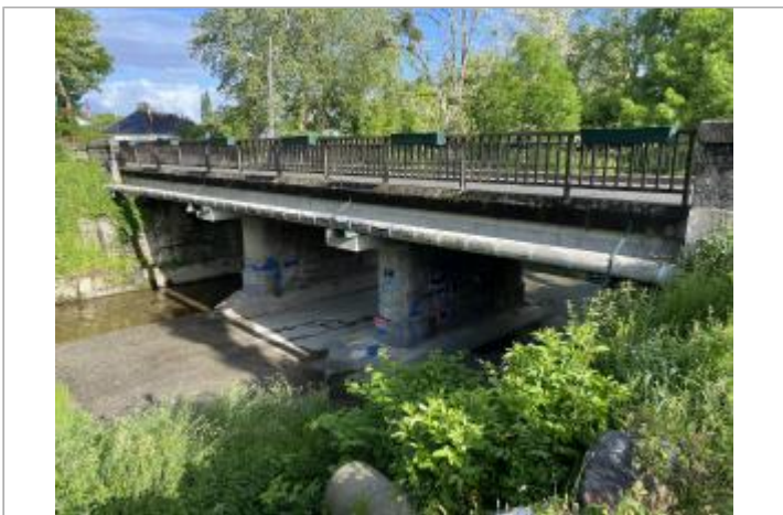
Vue du pont - auteur : SPC GAD
