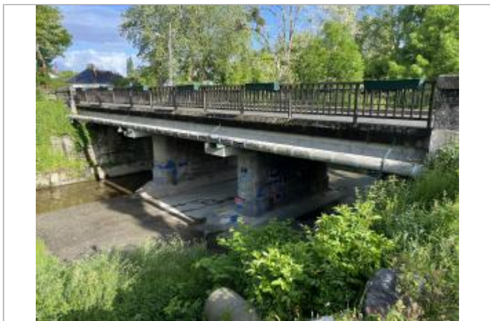
Vue du pont - auteur : SPC GAD
