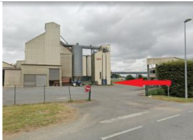
Entreprise agro-alimentaire, ancien puit (disparu)
