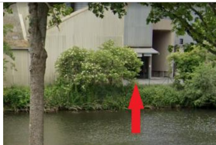
Bâtiment entreprise agro-alimentaire coté Blavet
