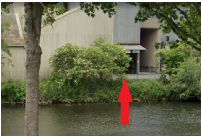
Bâtiment entreprise agro-alimentaire coté Blavet
