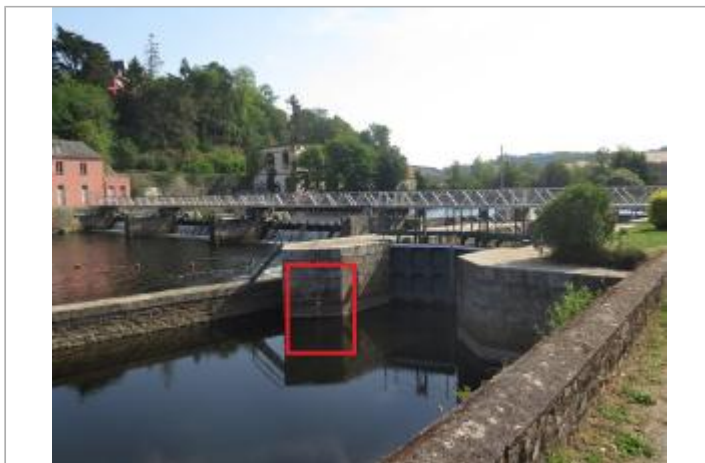
Aval de l'écluse du grand barrage à Hennebont
