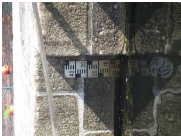
Echelle amont de l'écluse du grand barrage à Hennebont
