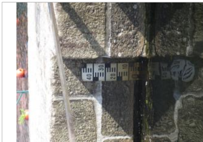
Echelle amont de l'écluse du grand barrage
