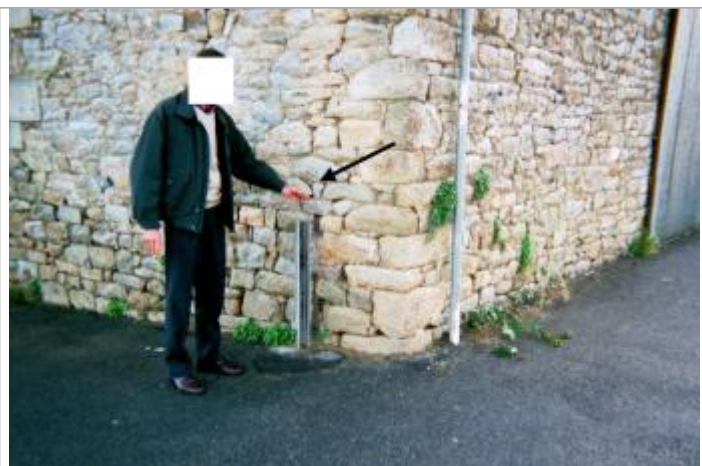
Batardeau de protection à l'angle de la rue du halage
