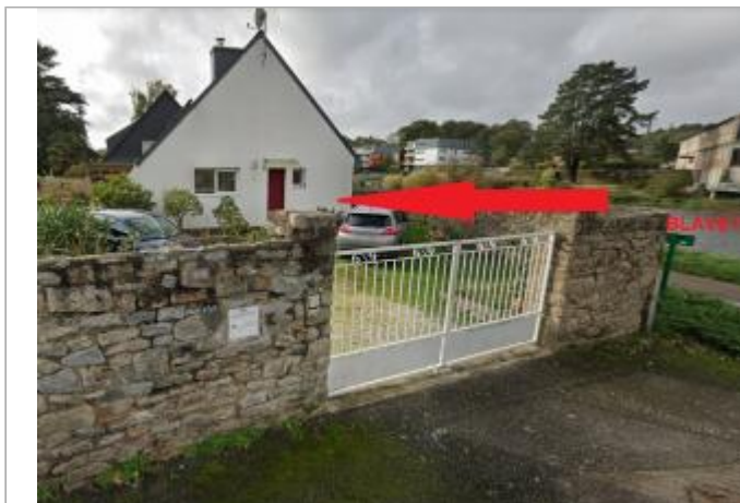
maison au 2 rue du halage à Hennebont
